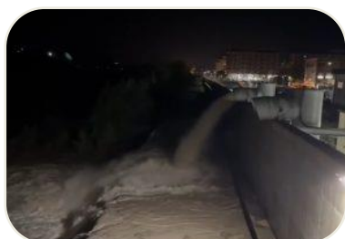
MANUTENZIONE DEGLI IMPIANTI IN CONVENZIONE CON GLI ENTI LOCALI
